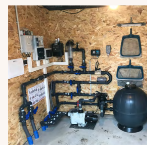
7. Réalisation de la filtration et mise en service
