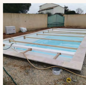
6. Pose des margelles* et mise en eau
