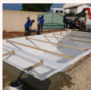
5. Création de l'assise béton
