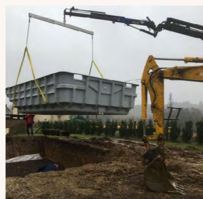
2. Livraison et pose de la piscine
