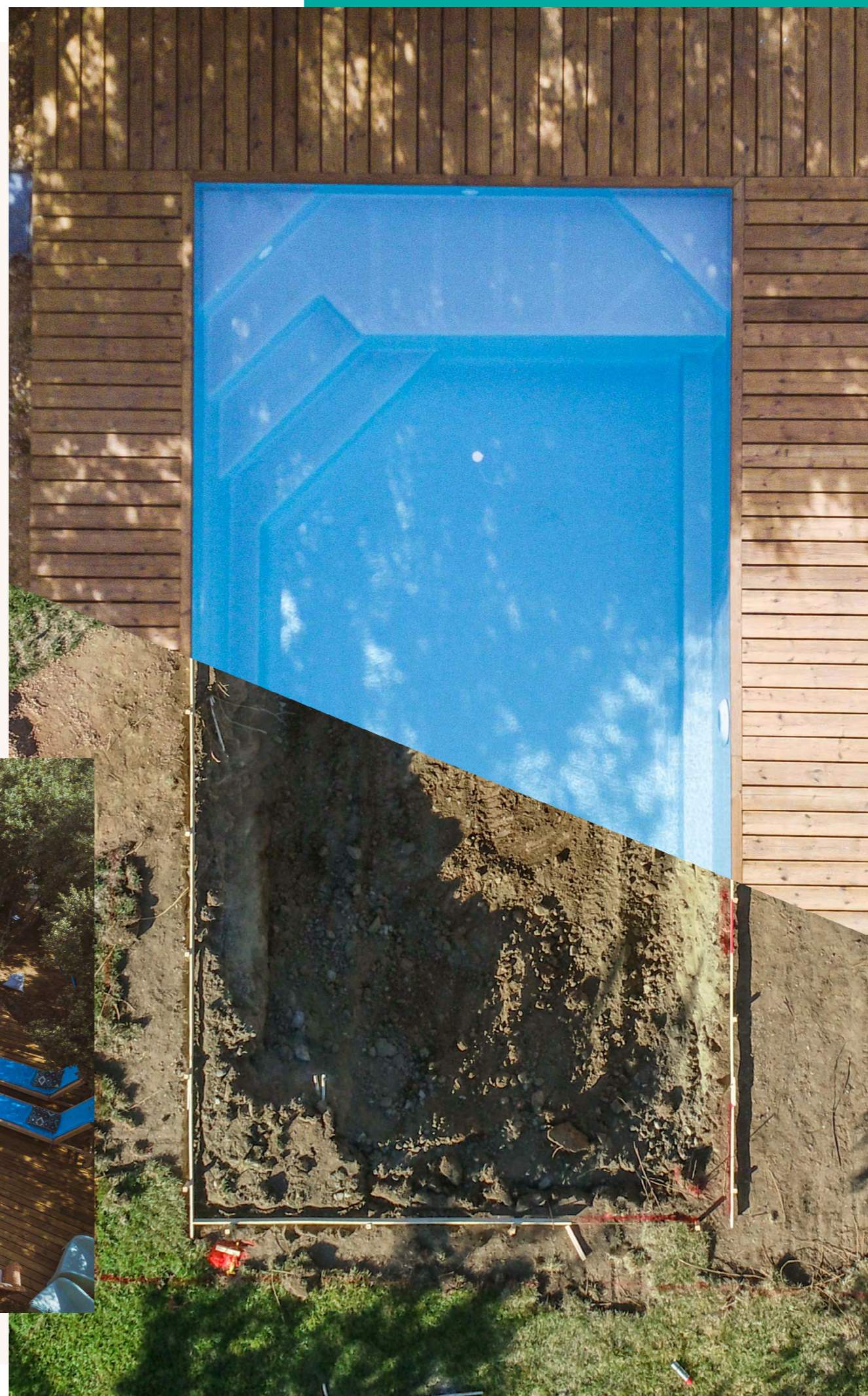
6. Pose des margelles* et mise en eau
